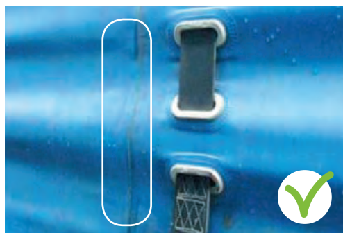
Bonne réparation du panneau intérieur avec les bords de l'entaille bien rapprochés et droits.
