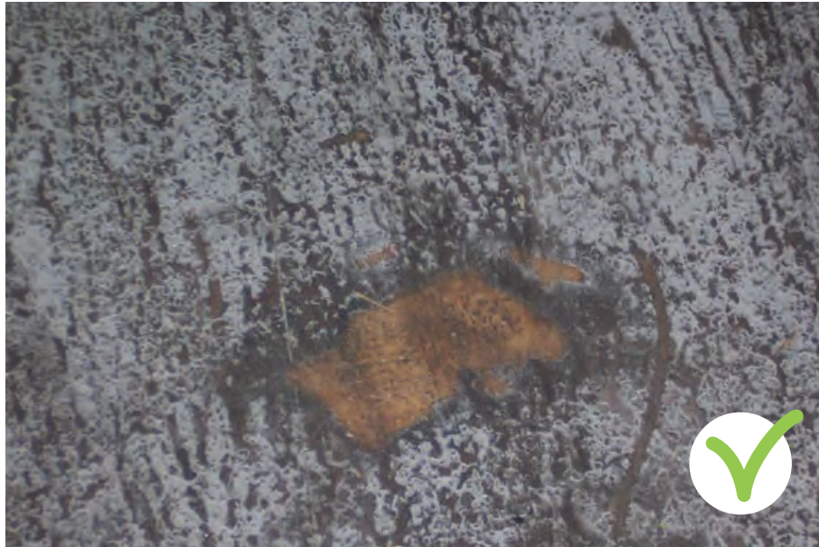
Usure de la couche supérieure en résine de protection du plancher.
