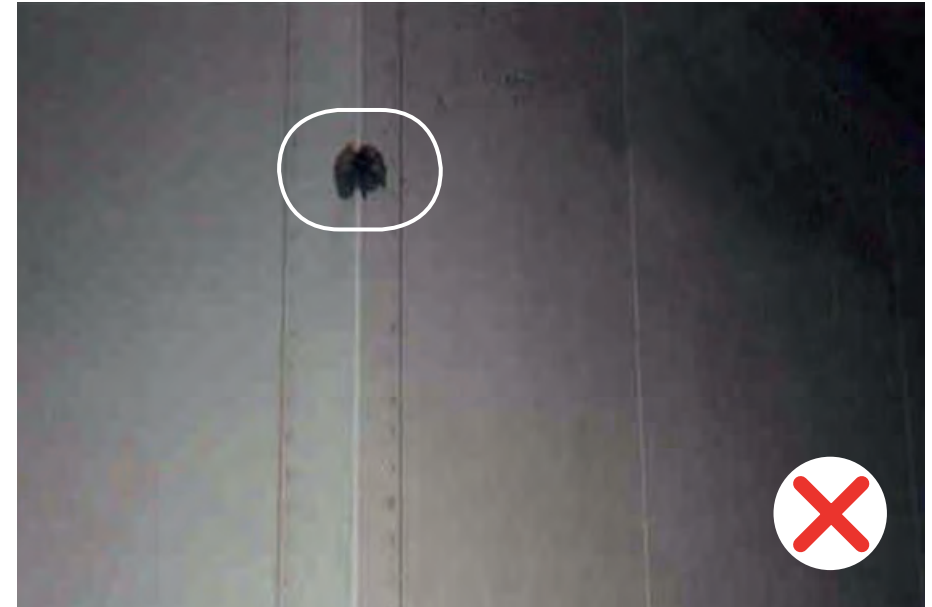
Poteau d'angle endommagé suite à une collision, avec absence de la peinture superficielle.
