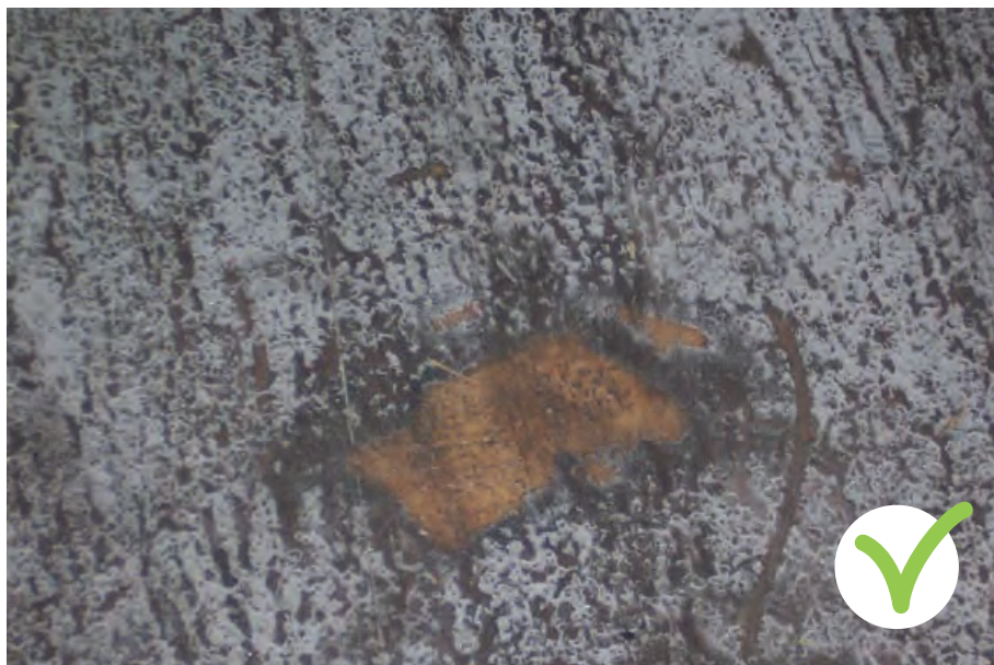
Strato protettivo di resina sopra il pavimento logorato.
