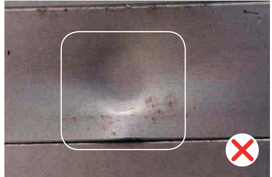
Pannello di accesso laterale danneggiato a causa di urti, non infiltrato ma profilo distorto.
