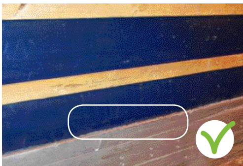
Pannello di accesso laterale danneggiato ma non forato, distorsione accettabile nella misura in cui non impedisce il funzionamento dell'accesso.
