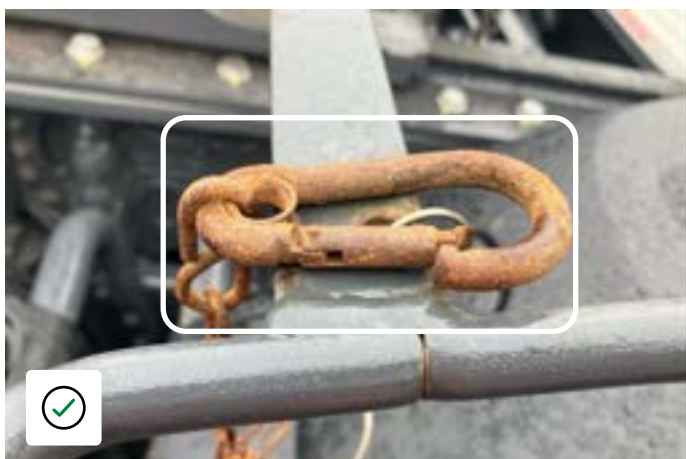
Vendehjulsholder rusten - slitasje
