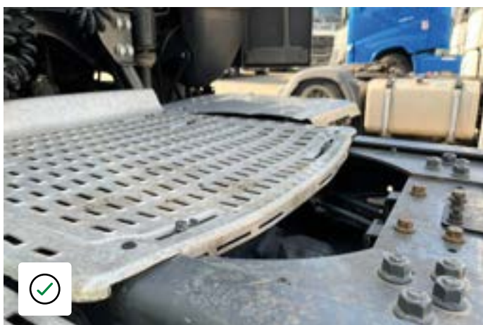
Mindre deformasjoner som følge av normal slitasje
