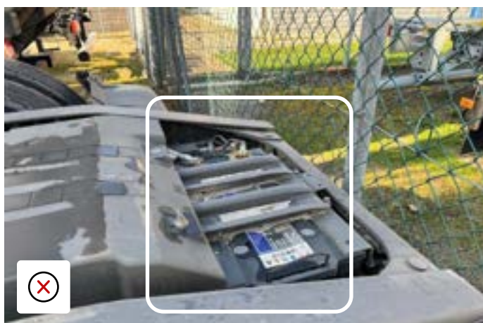
Batterideksel mangler - batteriet er eksponert for vær og vind
