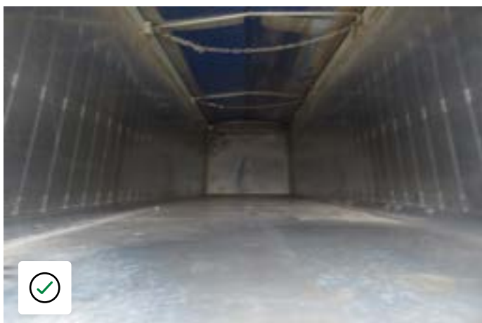
Gulvet er i akseptabel stand
