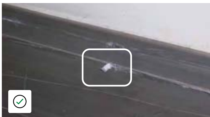
Eksempel på sparklist FW&T, skarp kant må slipes ned.
