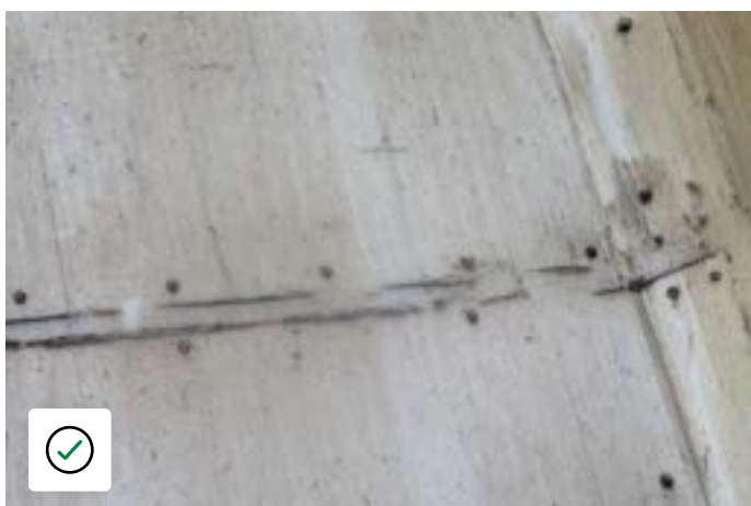
Gulvbeskyttelse med mindre riper - normal slitasje
