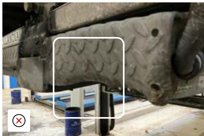
Plattform påkjørt på et kritisk sted - krever reparasjon
